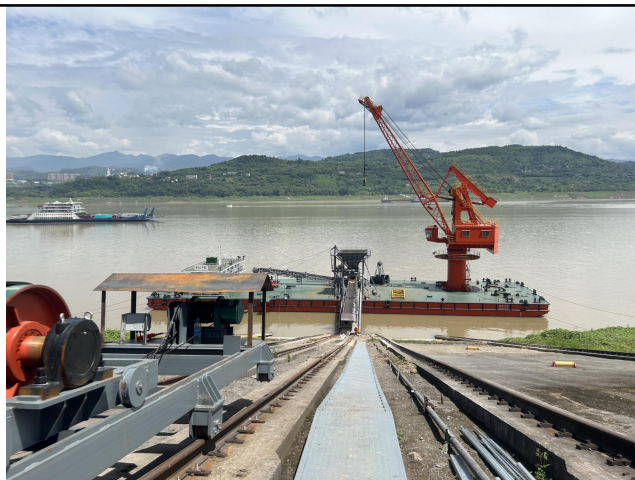
图 2.2-1 镇江码头 1#泊位现状
