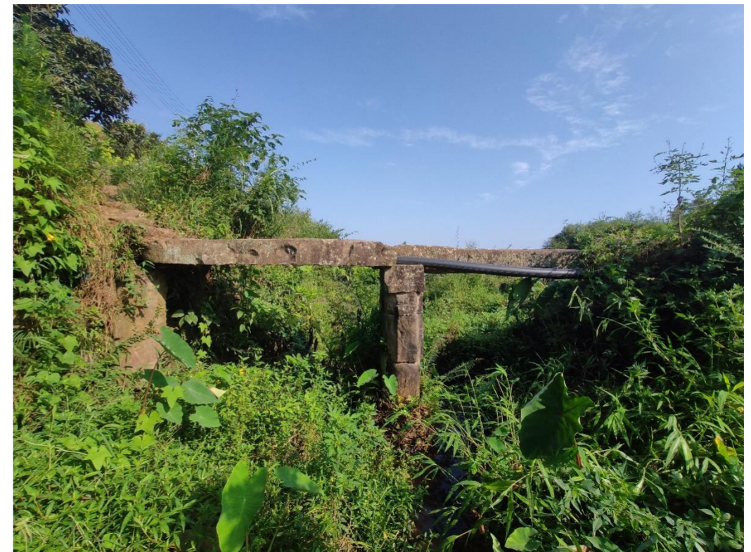
图 118 庙沟石平桥近景
